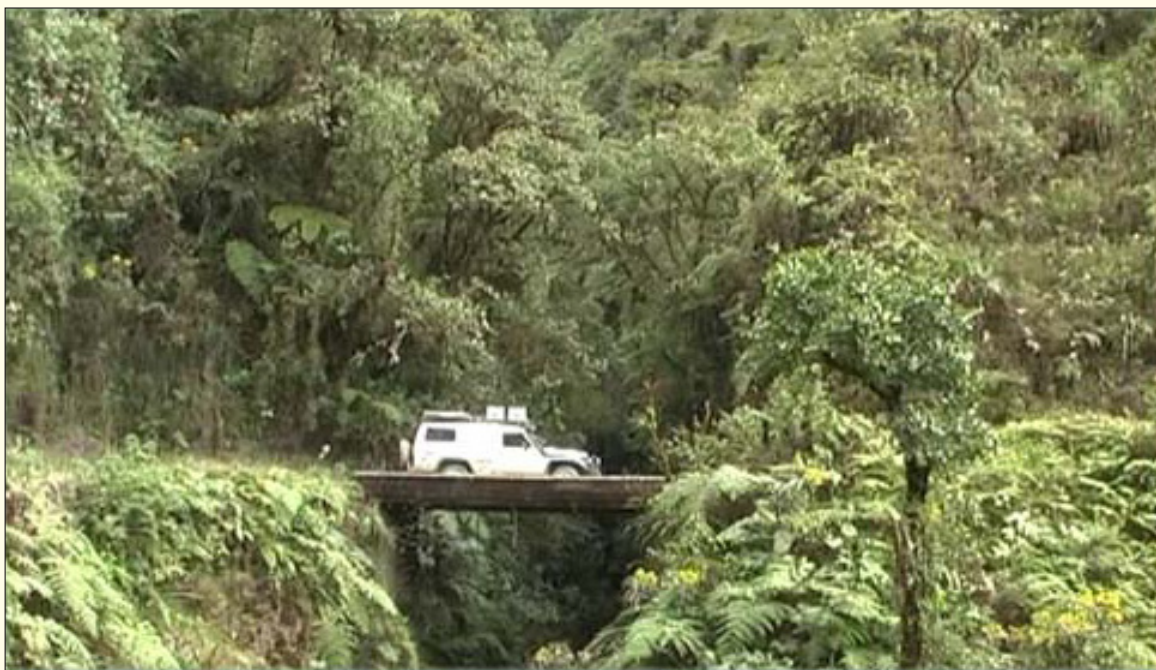
Paso puente a Yungas
