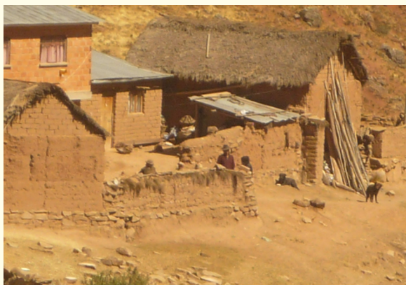
Vivienda - Valles Sur
