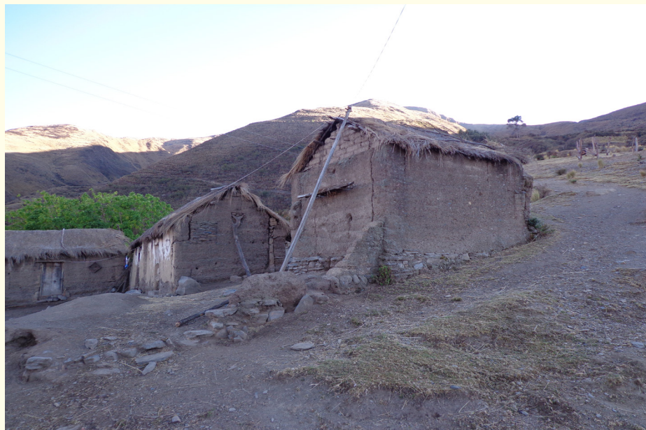
Vivienda - Valles Sur
